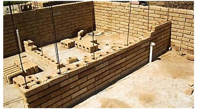
شكل رقم 7- البناء بطوب التربة المضغوطة بنفس الطرق التقليدية للبناء (9)
