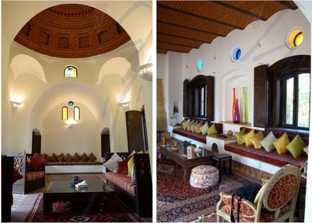
شكل رقم 29- تنفيذ الأسقف (قباب و أقبية) بوحدات طوب التربة المضغوطة (23)
